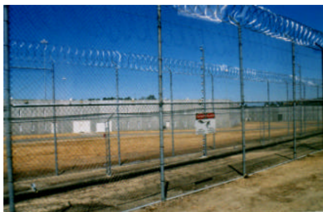
フェンスは三重 真ん中は電気フェンス
