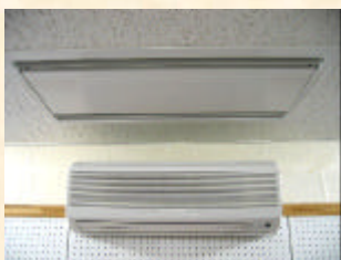
【空調設備 (廊下)】
