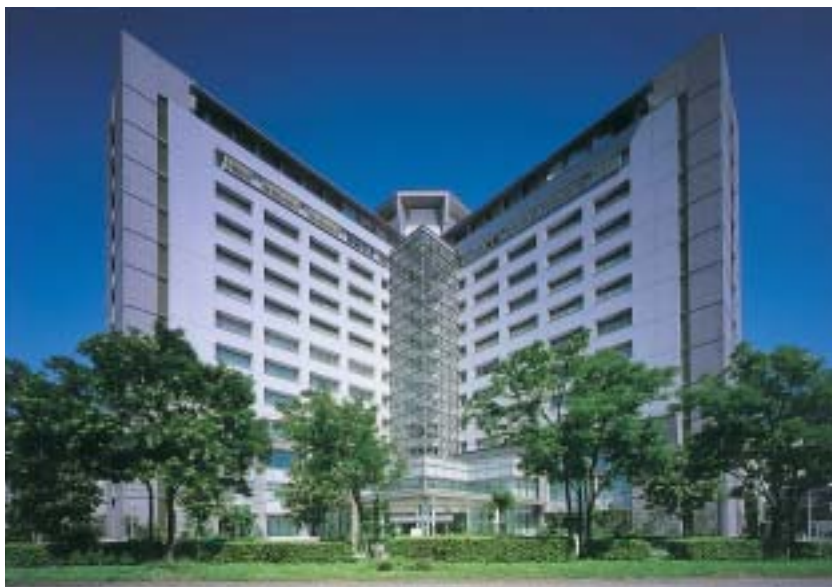
東京入国管理局新庁舎全景
