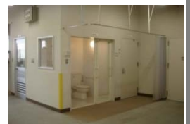
工場棟多機能トイレ
