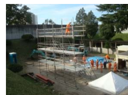
建築躯体科実習場
