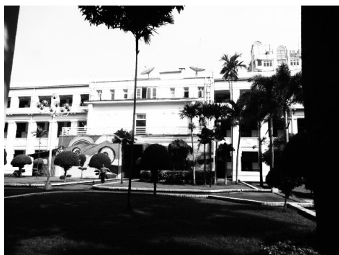
(ヤンゴン市開発委員会事務所が入っている建物)
