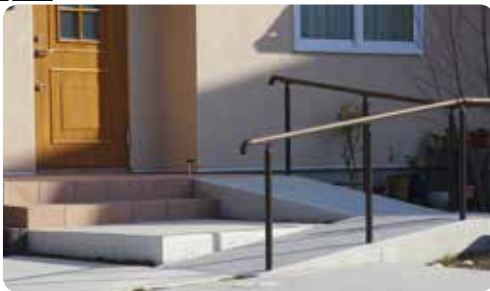
階段の横に用意されたスロープ
