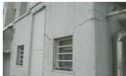
処遇管理棟 外壁の亀裂
