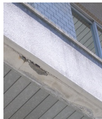
底部の一部崩落
