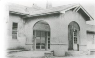
昭和18年竣工当時
