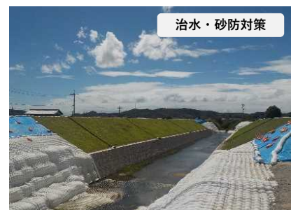
道路整備(橋梁設置)
