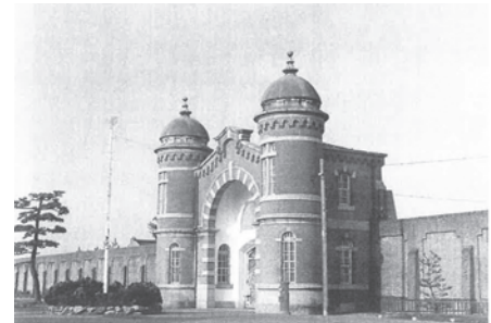
奈良監獄 〔1908(明治41)年に竣工〕
