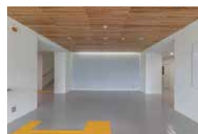
熊本刑務所庁舎エントランス(木質化(天井))
