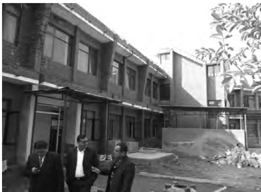
建設中のカトマンズ地検の新庁舎
