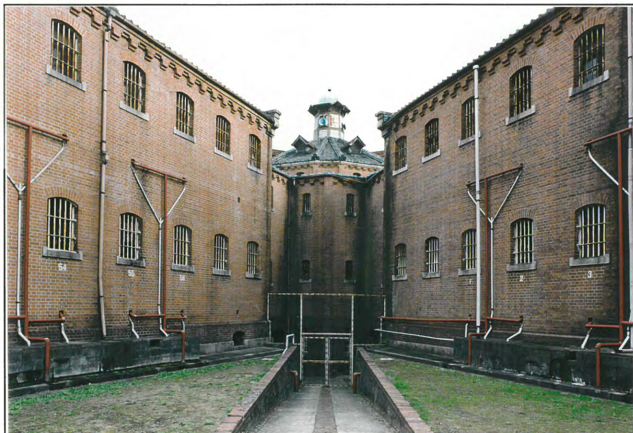
⑫第4・5寮（外観）・舎房渡廊下
