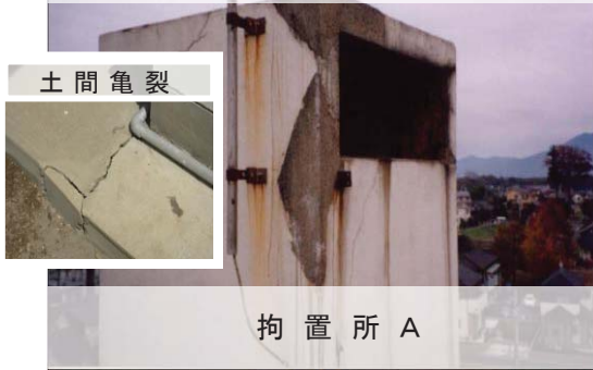
屋上煙突の劣化状況
