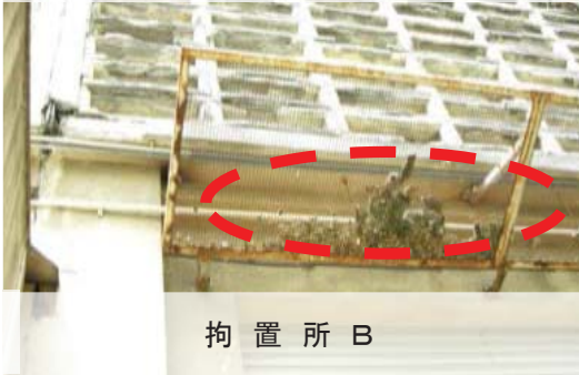
外壁のモルタル剥落状況
