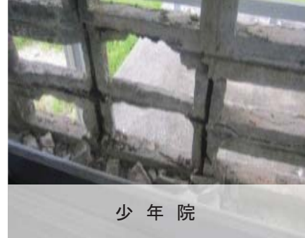
実科教室のコンクリート崩壊状況
