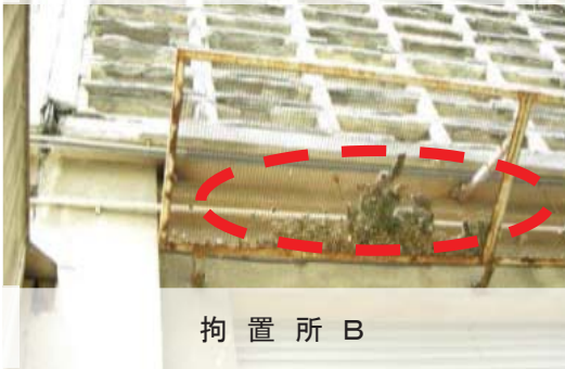
外壁のモルタル剥落状況
