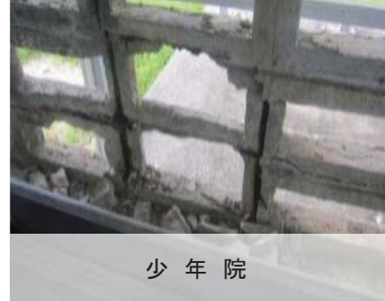
実科教室のコンクリート崩壊状況
