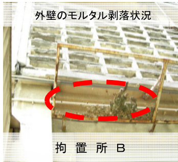
4階底の一部崩落状況
