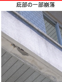
処遇管理棟 外壁の亀裂
