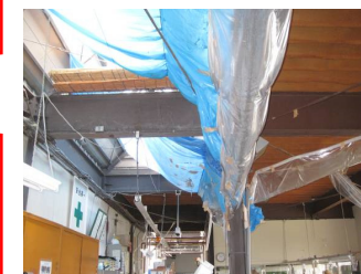
職業訓練棟の漏水対応状況
