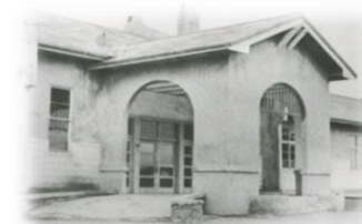
昭和18年竣工当時
