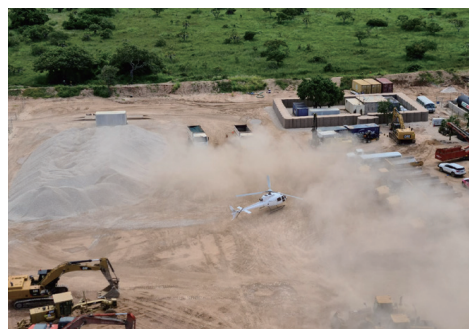
モザンビークのパルマで現地従業員等の救出活動を行うヘリ（写真提供: Dyke Advisoy Group/ロイター/アフロ）
