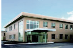
〒 328-8550 栃木市惣社町 2484 栃木刑務所
