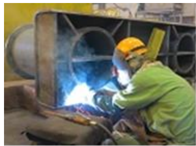
作業風景(溶接)
