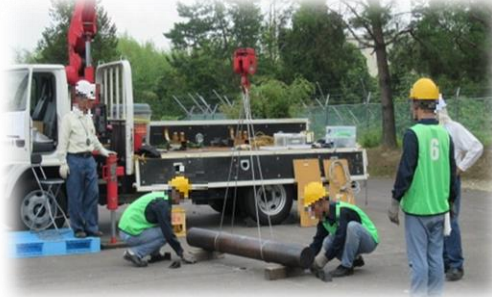
玉掛け技能講習 (総合建設科)
