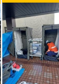
シャワーブース設置
