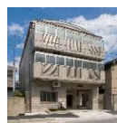
全面改築後の更生保護施設外観
