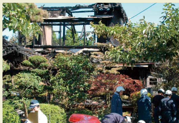
②自民党衆院議員宅放火事件（平成18年8月） (写真提供：共同通信社)
