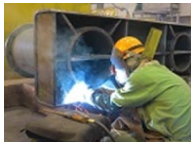
作業風景（溶接）
