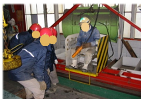
有井作業場 クレーン作業
