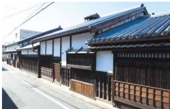
鉄炮鍛冶屋敷の外観（堺市有形文化財建造物）
