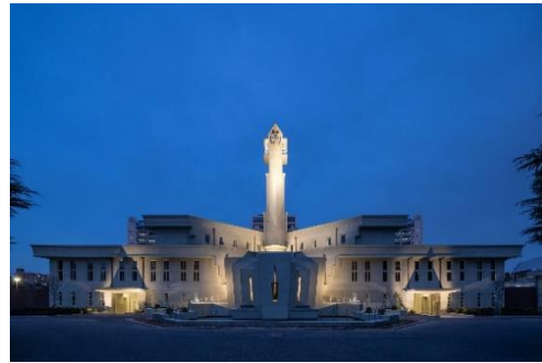
旧小菅刑務所庁舎(重要文化財)
