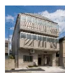
全面改築後の更生保護施設外観
