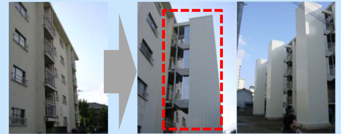
既存階段室踊り場に着床するエレベーターを設置
