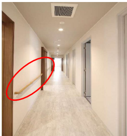
廊下に手すりを設置
