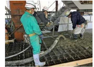
[Menggunakan pompa tekanan untuk menuangkan beton ke dalam bekisting]
