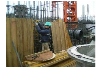
[Merakit bekisting untuk menuangkan beton]
