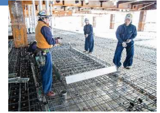
[Pemasangan bekisting baja pada besi beton (pekerja asing di sebelah kiri)]
