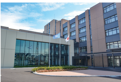
国際法務総合センター国際棟
